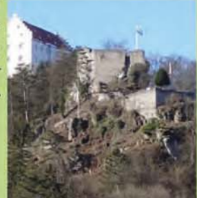
Blick auf die freigestellte Burgruine Rabenstein (Vordergrund) und die Rosenberg (Hintergrund) oberhalb von Riedenburg
